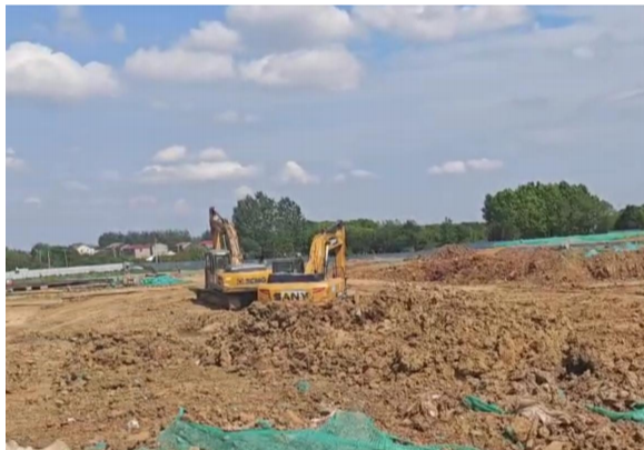
图 8-2 拟建门急诊病房楼南侧
