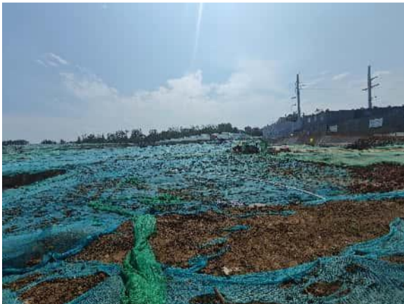
8-4 拟建门急诊病房楼北侧
