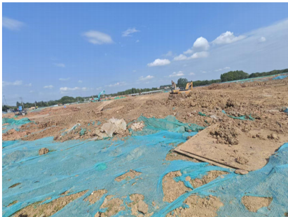
图 8-1 拟建门急诊病房楼东侧
