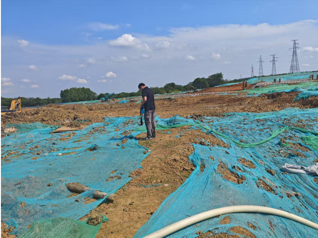
图 8-5 门急诊病房楼拟建址
