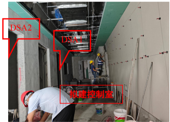
图 8-1 拟建 DSA 机房东侧空房间
