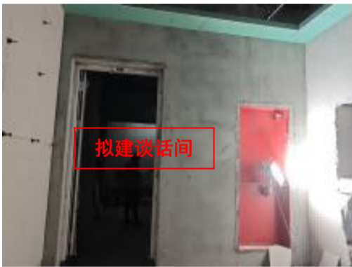
图 8-2 拟建 DSA2 机房东侧空房间
