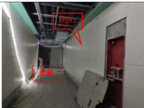
图 8-5 拟建 DSA2 机房南侧走廊
