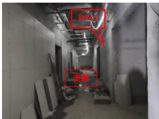
图 8-7 拟建 DSA 机房北侧走廊
