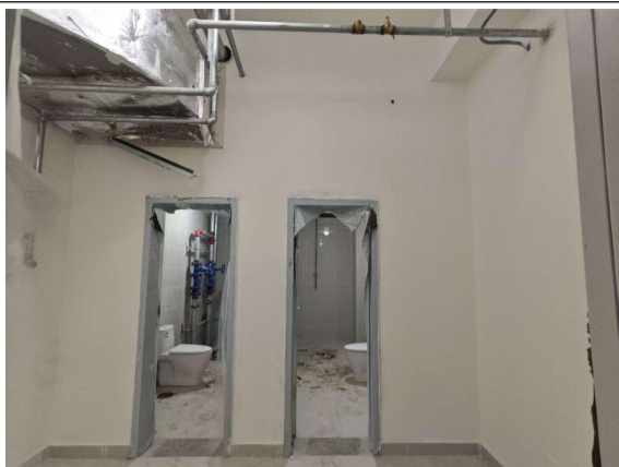
8-13 拟建 DSA2 机房下方 B2 层空房间
