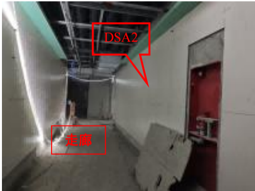
图 8-3 拟建 DSA2 机房南侧走廊
