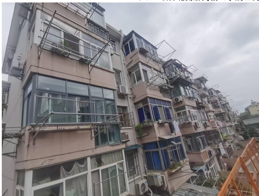
图 8-15 项目南侧居民楼（佳诚花园 21 号楼）
