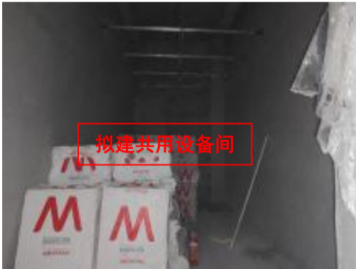
图 8-4 拟建 DSA1 机房南侧（DSA2 机房北侧）空房间
