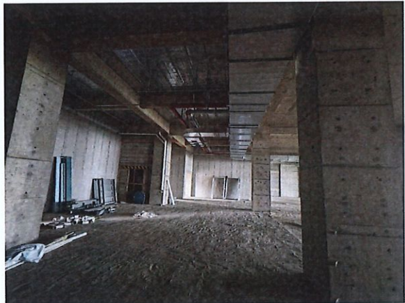
图 8-2 拟建 DSA 机房南侧（空场地）
