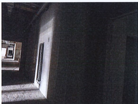
图 8-5 拟建 DSA 机房下方（空房间）
