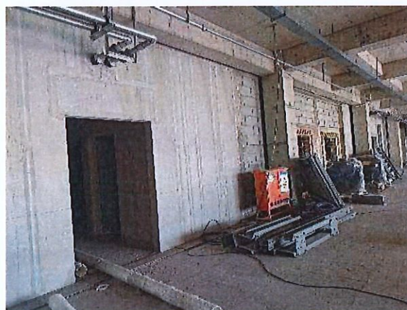
图 8-6 拟建 DSA 机房上方（空房间）
