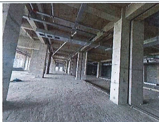
8-4 拟建 DSA 机房北侧（空场地）
