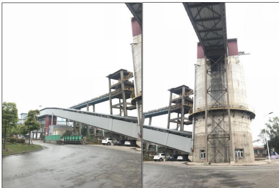
图 3.2-3 水运进煤系统密闭廊道、转运站现场照片
