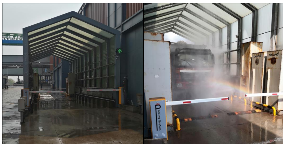
图 8.2-7 冲洗平台现场照片
