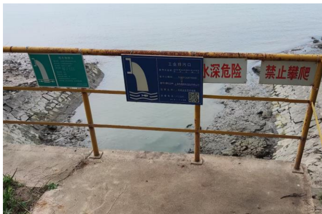
图8.2-11 九号路沿线雨排口现场影像图
