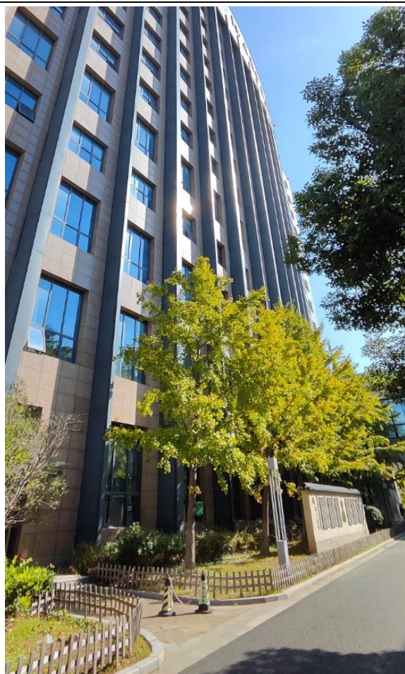
拟建址处东北侧（住院楼）
