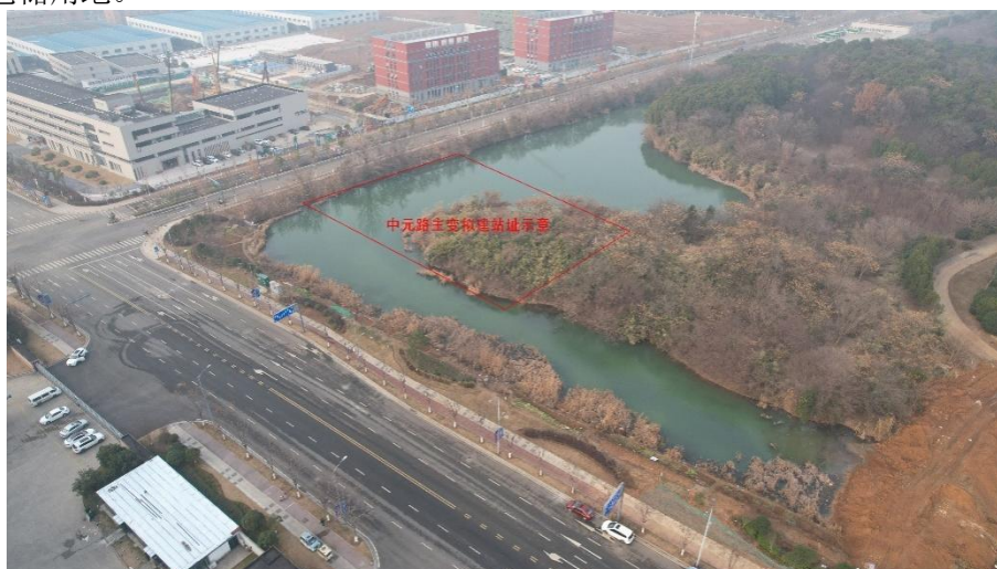
图3.2-1 拟建站址现状航拍图
