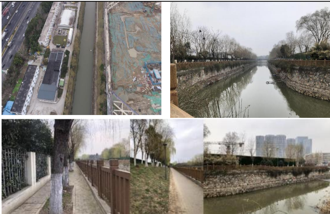
图3-3 朱家河-绿都大道段明渠现状照片
