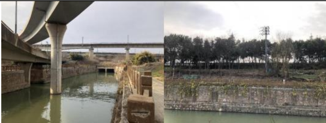
图3-9 绕城高速-高铁轨道段明渠现状照片
