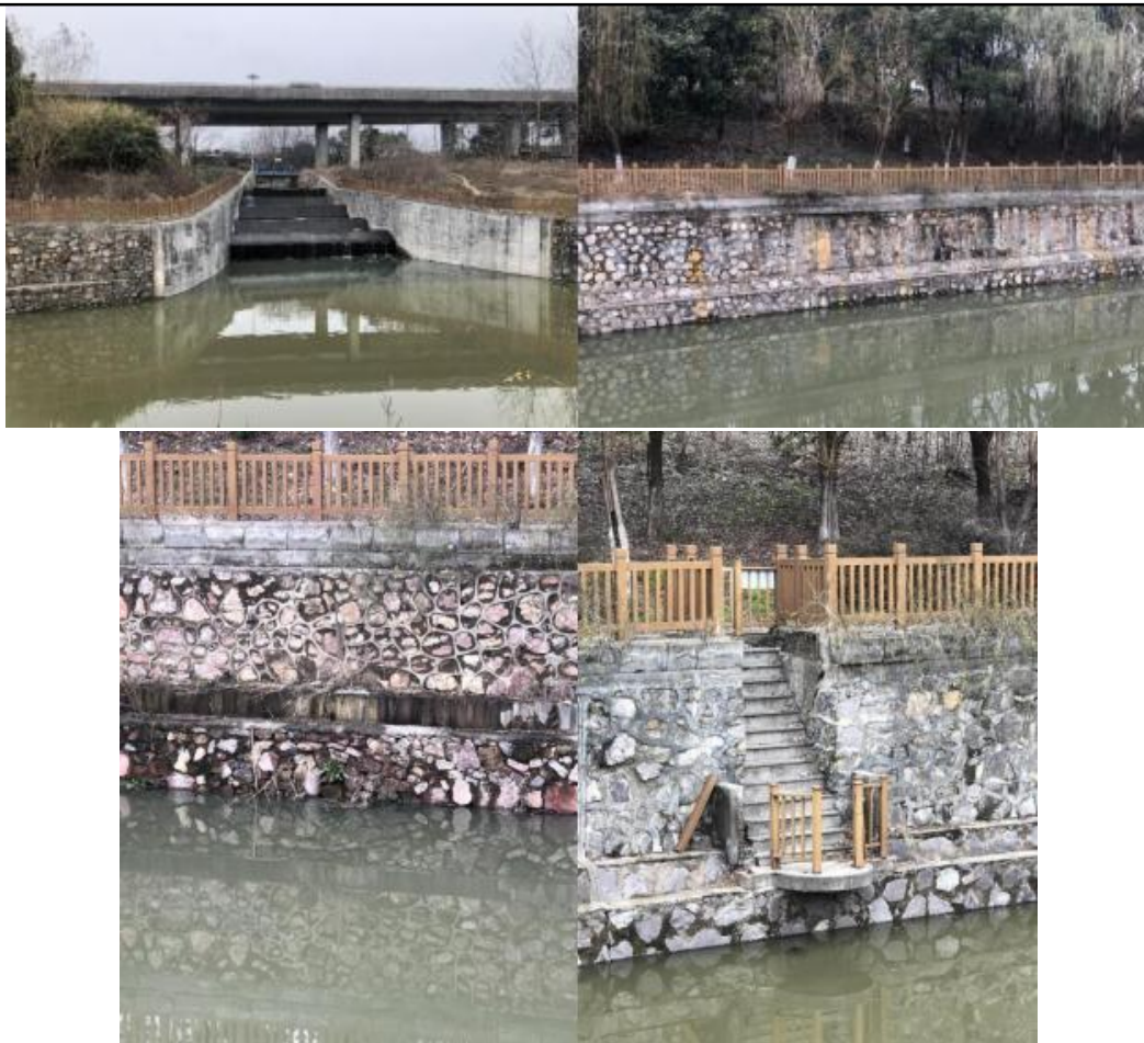
图3-7 绕城高速-高铁轨道段明渠现状照片
