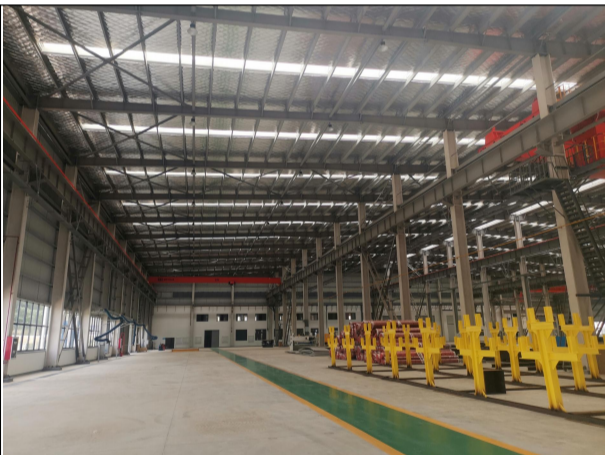
装置拟建址南侧1#生产车间
