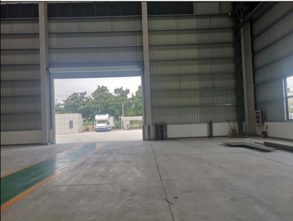
装置拟建址北侧 1#生产车间
