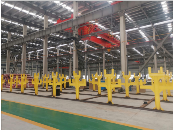
装置拟建址西侧 1#生产车间
