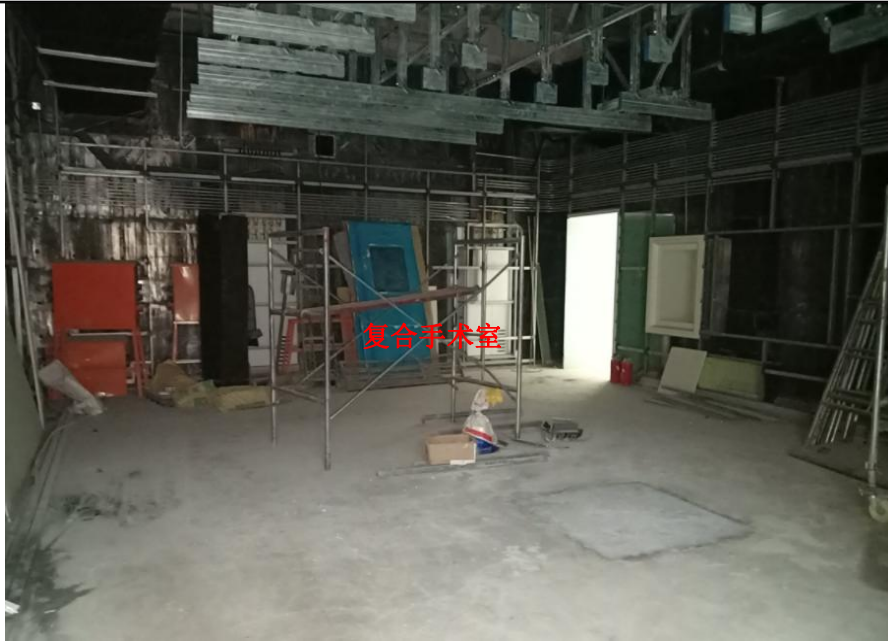
图 8-1 门诊医技楼五楼复合手术室 DSA 机房拟建址
