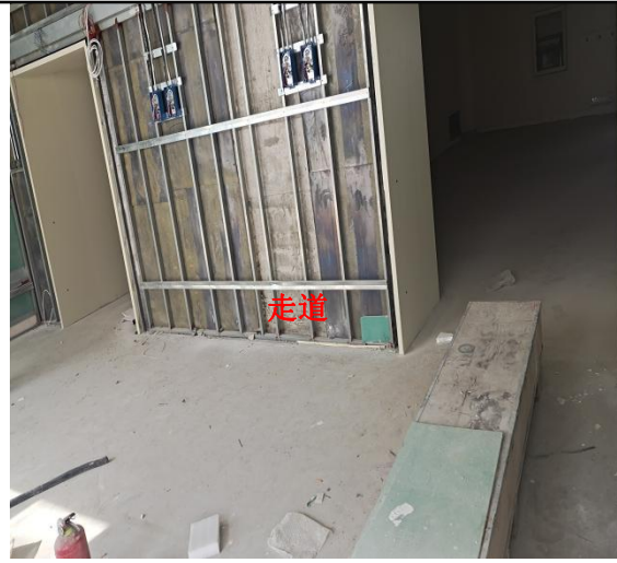
机房南侧走道
