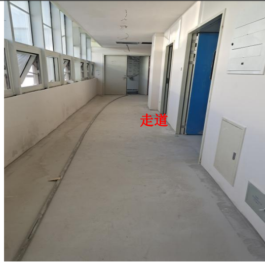
机房北侧走道
