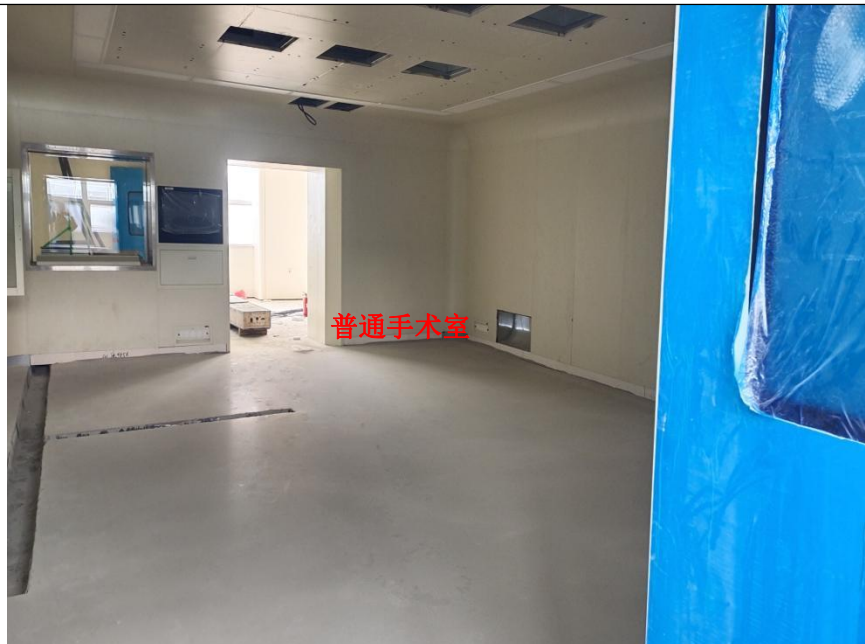
图 8-2 门诊医技楼五楼普通手术室 DSA 机房拟建址
