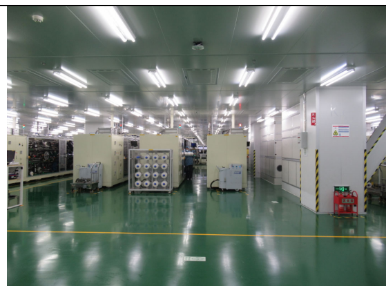
2 号工业 CT 装置拟建址南侧（走廊和 Lami 产线）
