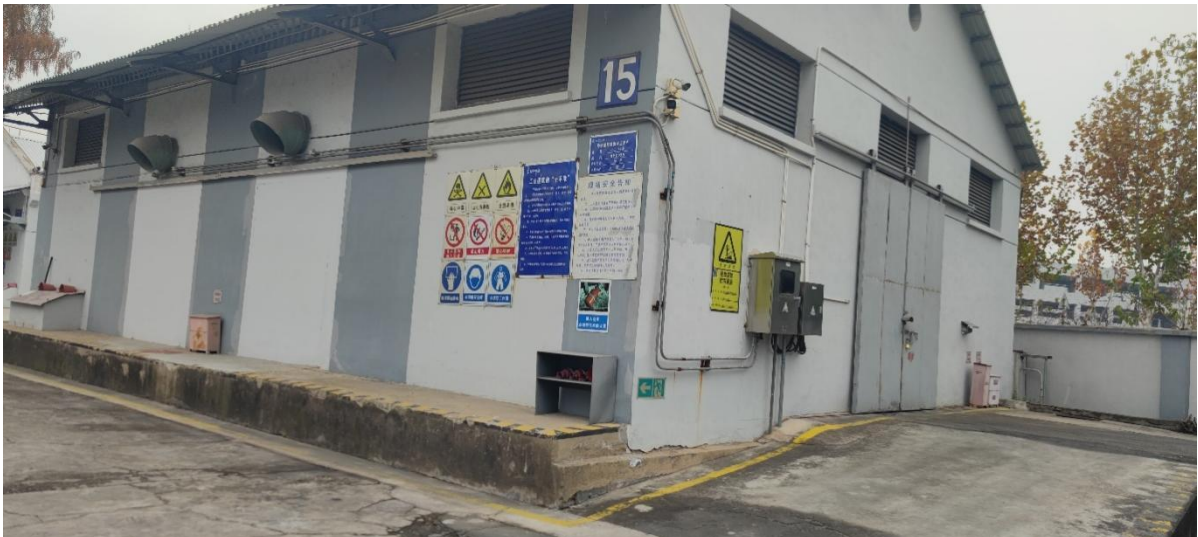
危废暂存库照片
