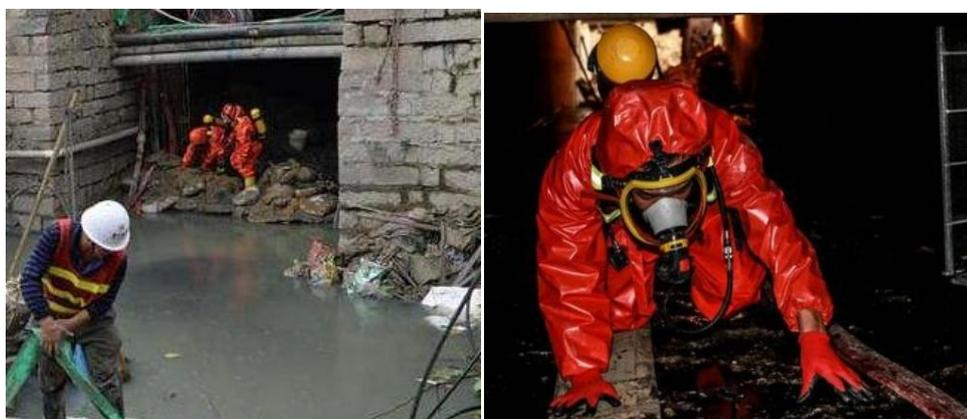
图 2.5-1 人工倒运清淤法示意图
