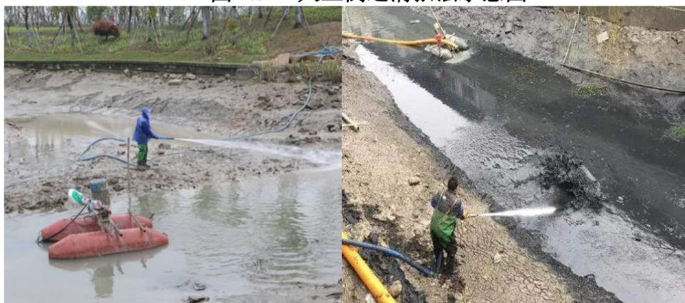
图 2.5-2 水力冲刷清淤法示意图
