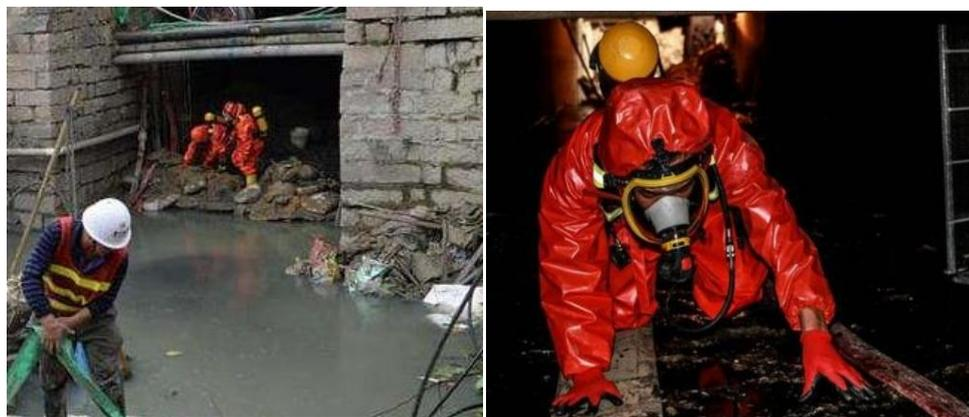
图 2.5-1 暗涵人工倒运清淤法示意图
