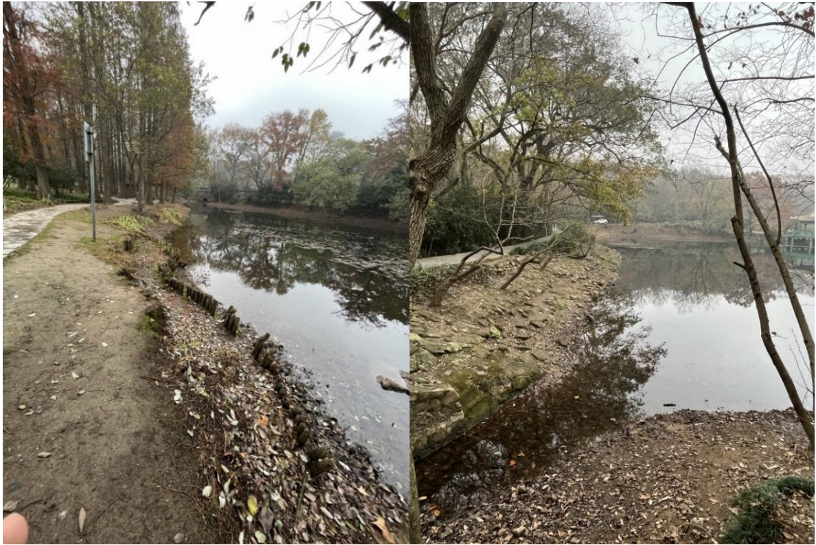
图 3.1-6 流徽湖护坡现状照片
