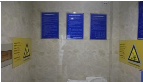
图 2-6 依托危废间现场照片（E2 栋）
