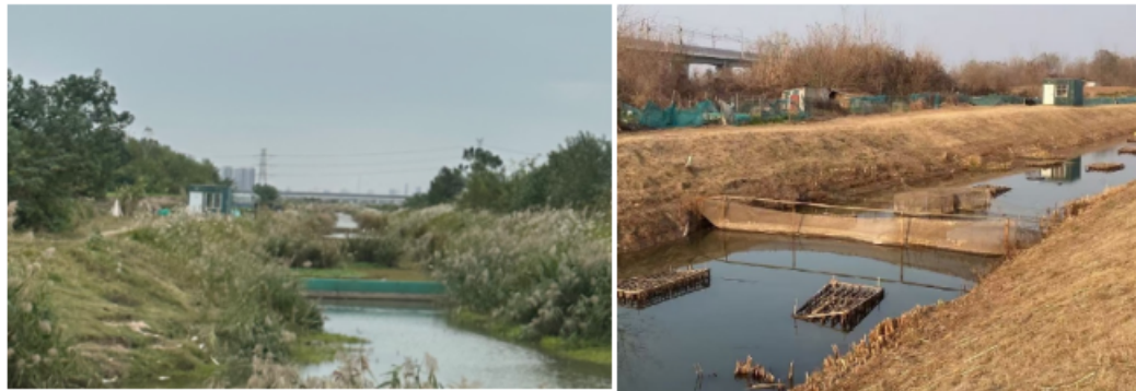
图 3-1 河道岸坡现状
