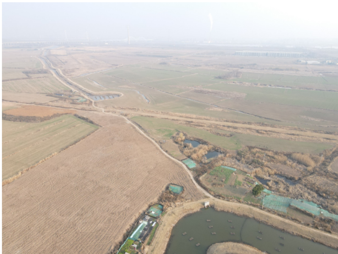
图 3-1 河道岸坡现状
