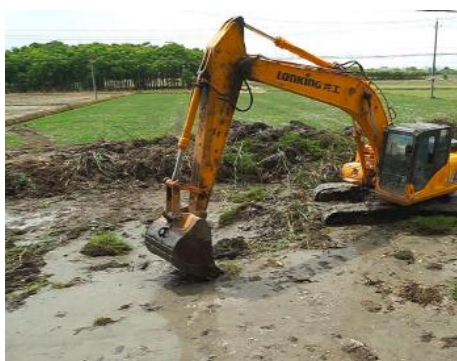
图 2-6 河道干挖清淤示意图
