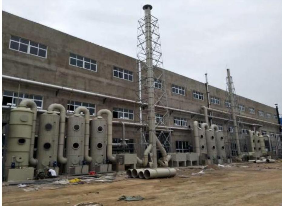
图 4-3 本项目拟采用的洗涤塔示意图
