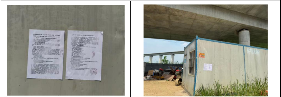
宁盐高速公路施工场地办公房 1
