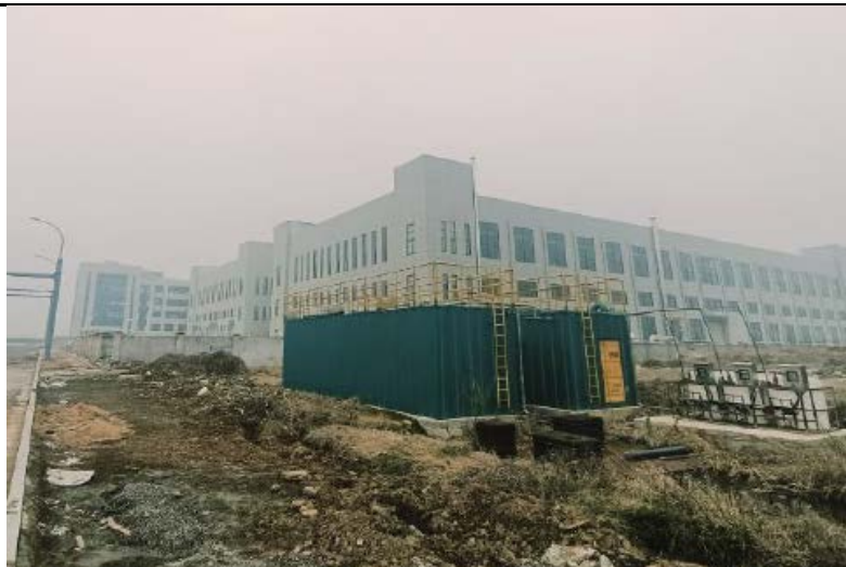
图 4-3 雄州街道污水处理设施
