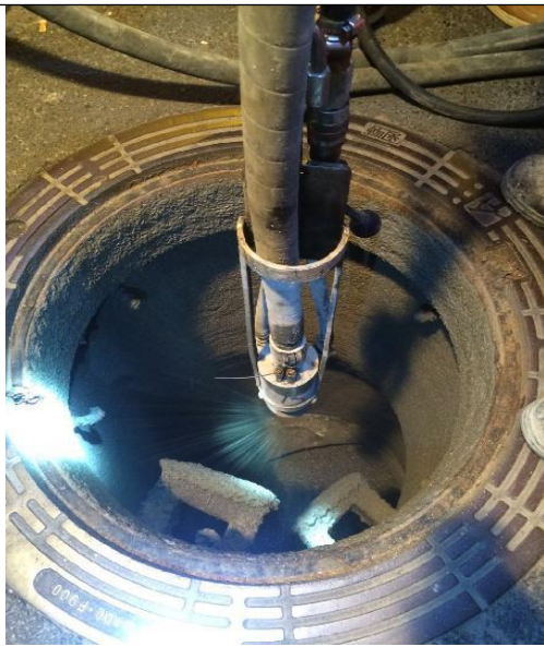
污水检查井修复过程照片
