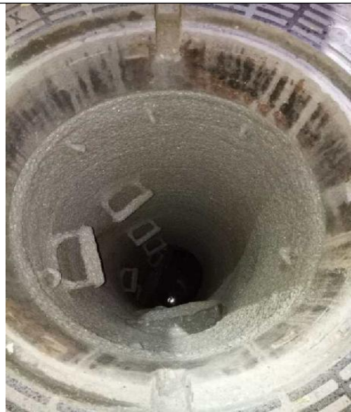
污水检查井修复过程照片
