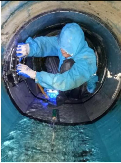
不锈钢快速锁修复过程照片
