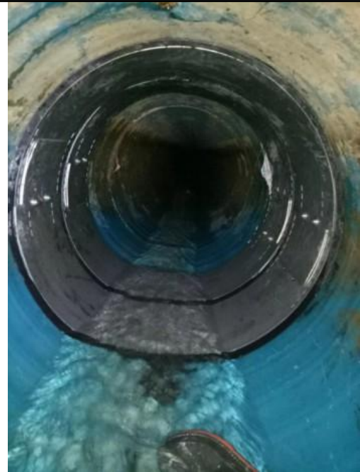
不锈钢快速锁修复过程照片
