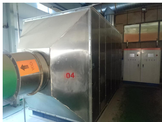
图 4-3 依托废气处理设施照片
