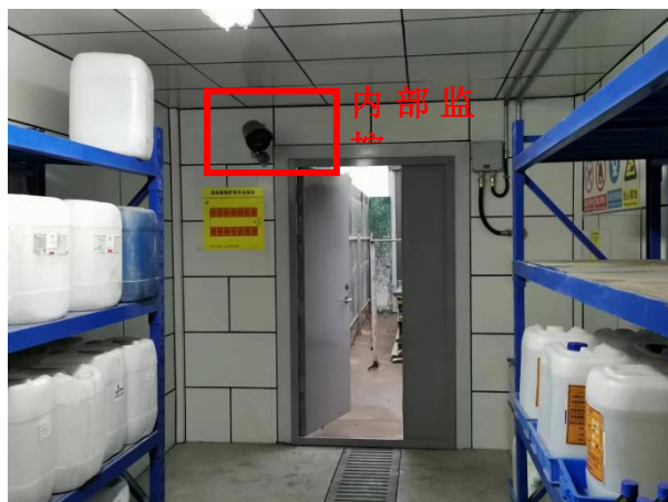
内部分区及内部监控
