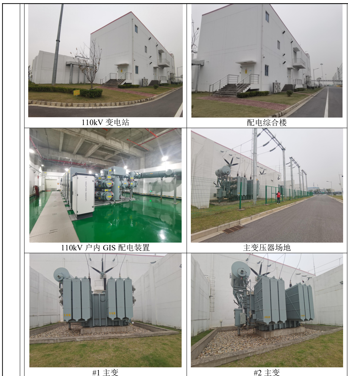
图 2-1 变电站现状照片
